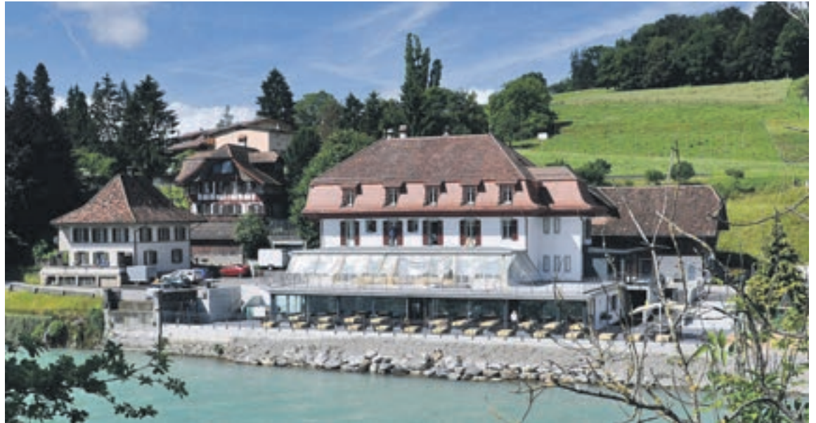
Der Landgasthof Thalgut nach dem Umbau. Beim Besuch von DURST fehlten nur noch die Storen.
